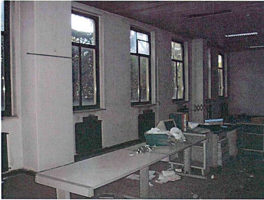
Interno uffici – palazzina (2)
